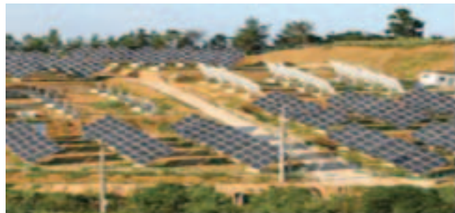
〈그림 3〉 산림을 훼손하면서 건설된 태양광발전소
